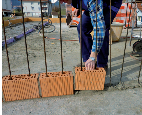
5. Setzen des ARMO-Steines
