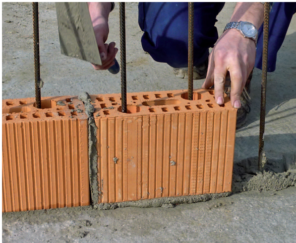
6. Das Mauerwerk muss vollfugig erstellt werden
