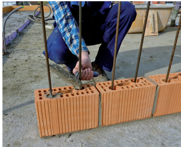
7. Die Bewehrungslöcher müssen vollständig verfüllt werden.
